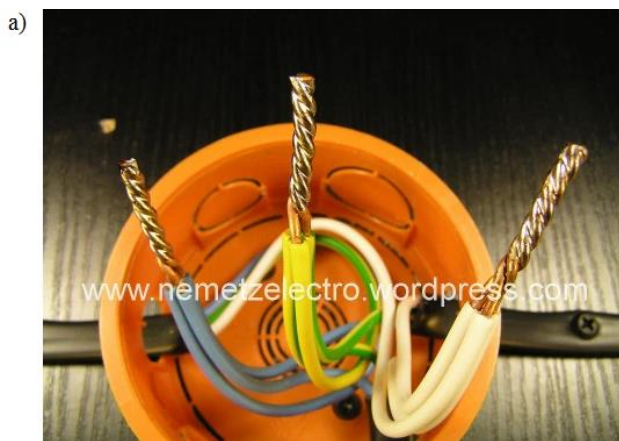
Результат лужения многожильного провода: а) отлично; б) удовлетворительно
